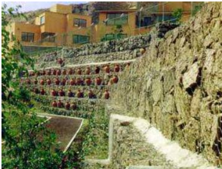
18) Gaviones que cumplen además una función ornamental (diseño arquitectónico)
