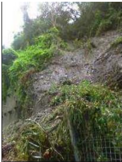
(3); (4) Deslave producido en talud frente a uno de los túneles del tramo ferroviario Caracas – Cúa en Venezuela.
